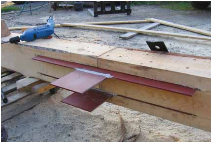
Alle skøyttar vert forsterka med stålinnlegg for å halde konstruksjonen endå betre på plass. (Foto: Kristian Williamsen)
