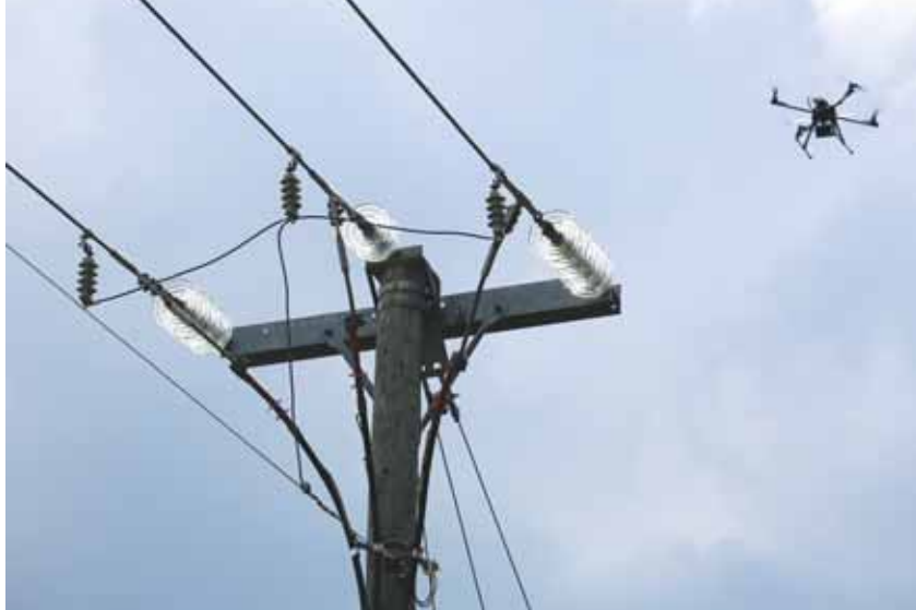
Multikopter som tar bilde av strømmast. (Foto: Jon Anders Krokann)
