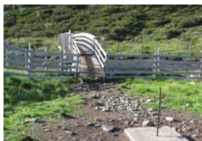
Her er brua som fører over elva ved Fossan. Delen nærast vangen kan løftast opp og bli ei rampe dyra må hoppe ned av. Saltsteinen er strategisk plassert.
