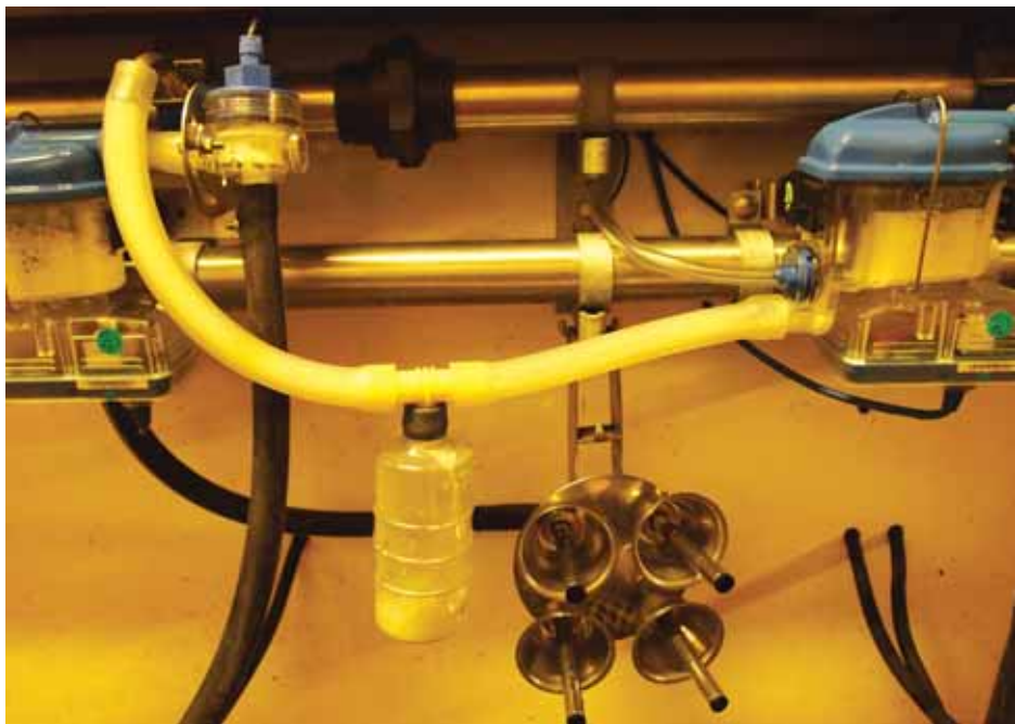
Fastmonterte mjølkemålarar gjer vegarbeid og prøveuttak enkelt. (Foto: Hege Gonsholt)
