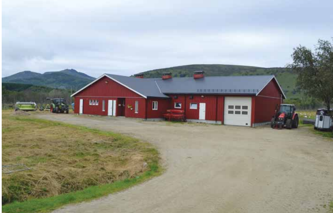
Driftsbygningen til Øyvind og Inger ble bygd i 2007.
