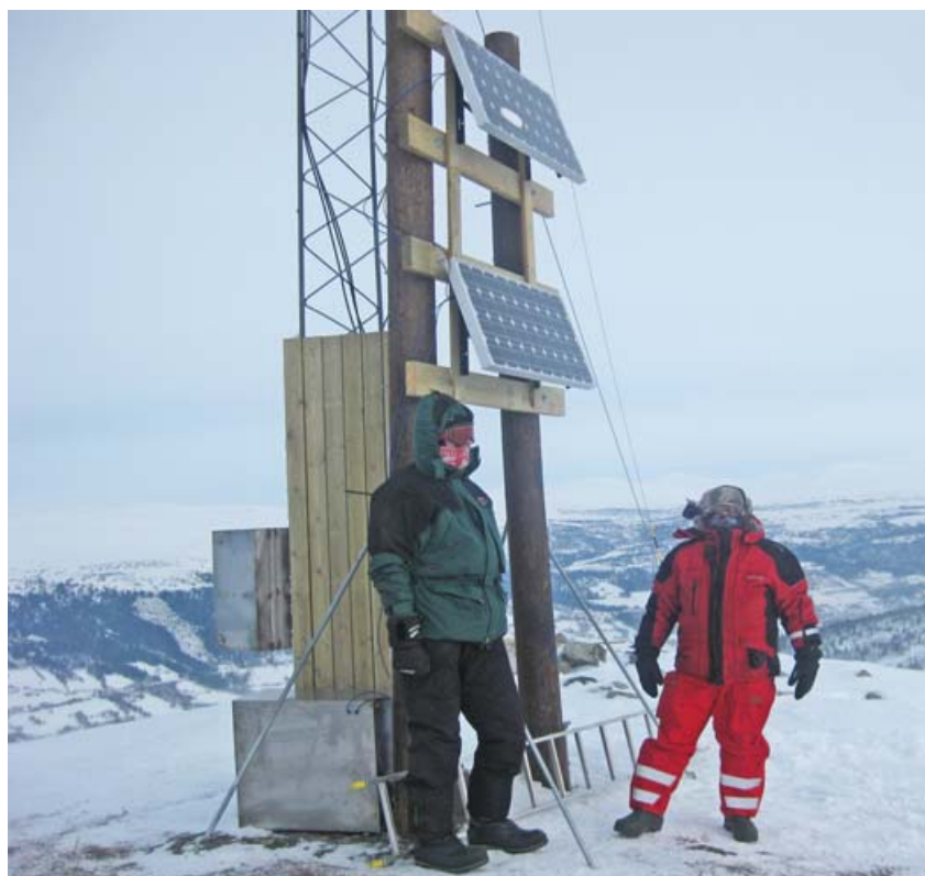
KREVENDE MONTERINGSARBEID: 5. februar 2012 var både Røde Kors' og Sikringsradioens utstyr på plass i den 17 meter høye radiomasta på Rogne. (Foto: Stig H. Morken)
