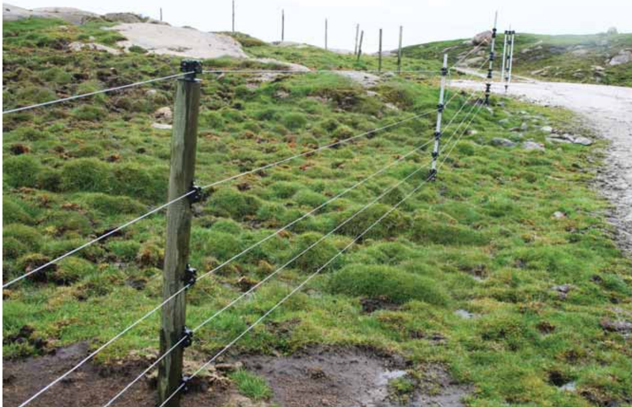
FLEKSIBELT: Veshovda gjerdesystem kan benytte både jern- og trepåler og er fleksibelt både i høyden og i forhold til terrenget.
